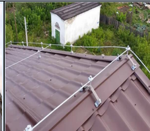
Сетчатый молниеприемник.
