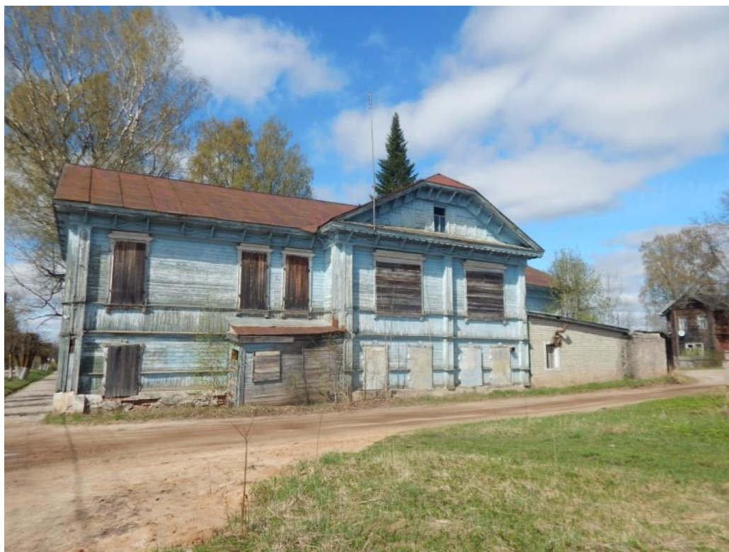
Фото 4. Вид со стороны восточного фасада
