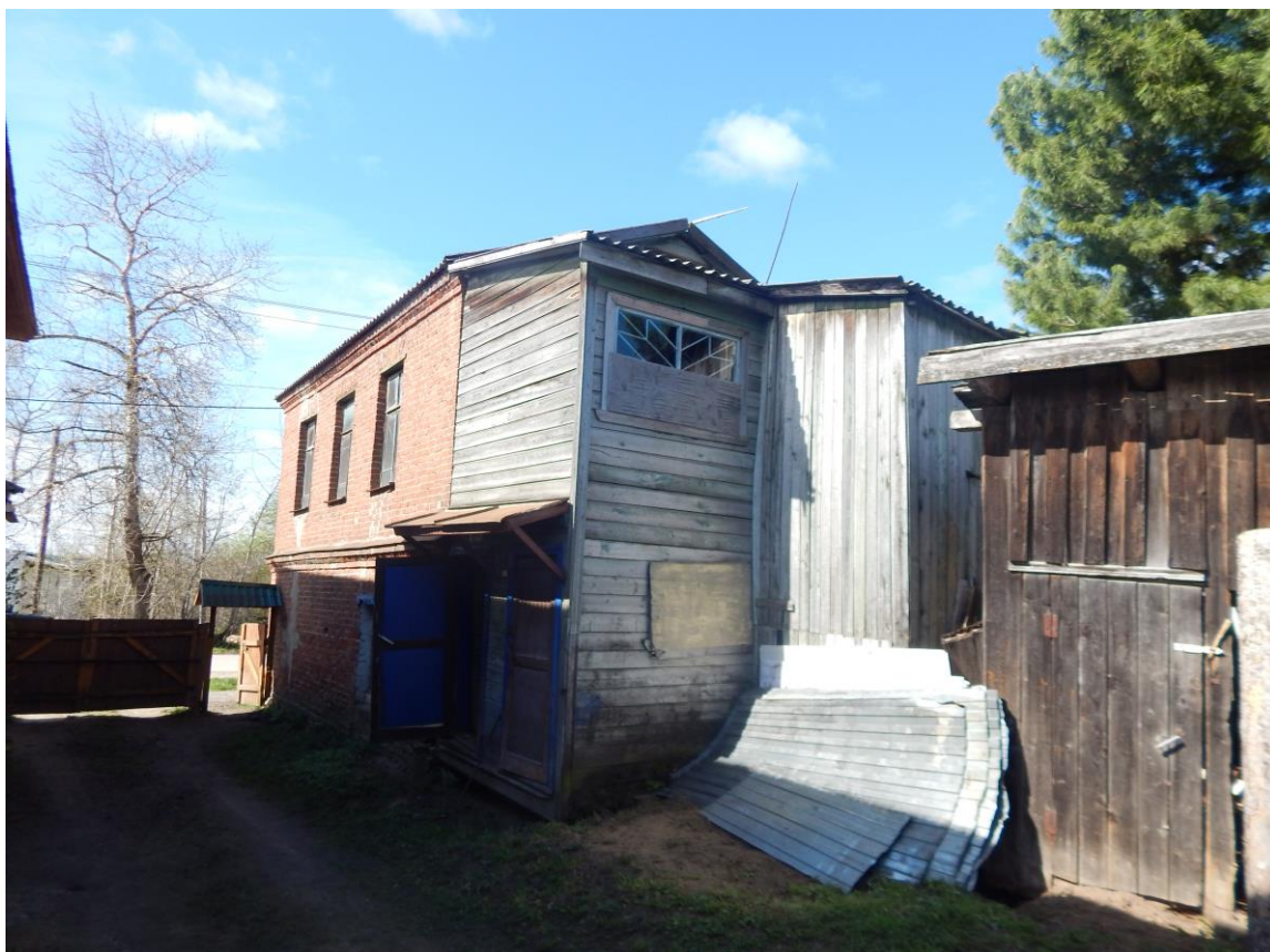
Фото 4. Вид со стороны северного фасада
