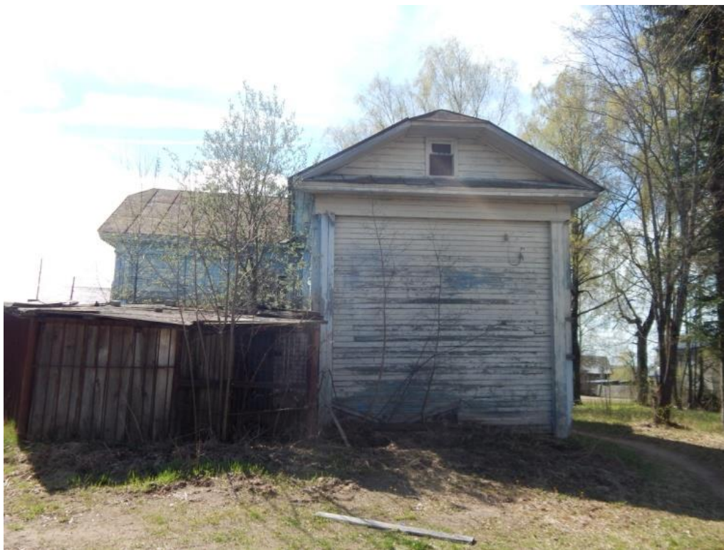
Фото 3. Вид со стороны северного фасада
